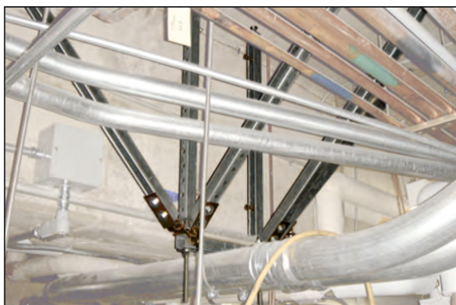
Рисунок 3.7, 3.8, 3.9, 3.10 Жесткое кабельное крепление (стальной стойкой) Применение на кабель-каналах и трубах (изображения из веб страницы Агентства чрезвычайных ситуаций www.fema.gov )
