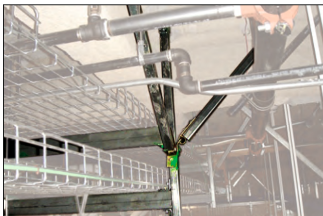
Рисунок 3.7, 3.8, 3.9, 3.10 Жесткое кабельное крепление (стальной стойкой) Применение на кабель-каналах и трубах (изображения из веб страницы Агентства чрезвычайных ситуаций www.fema.gov )
